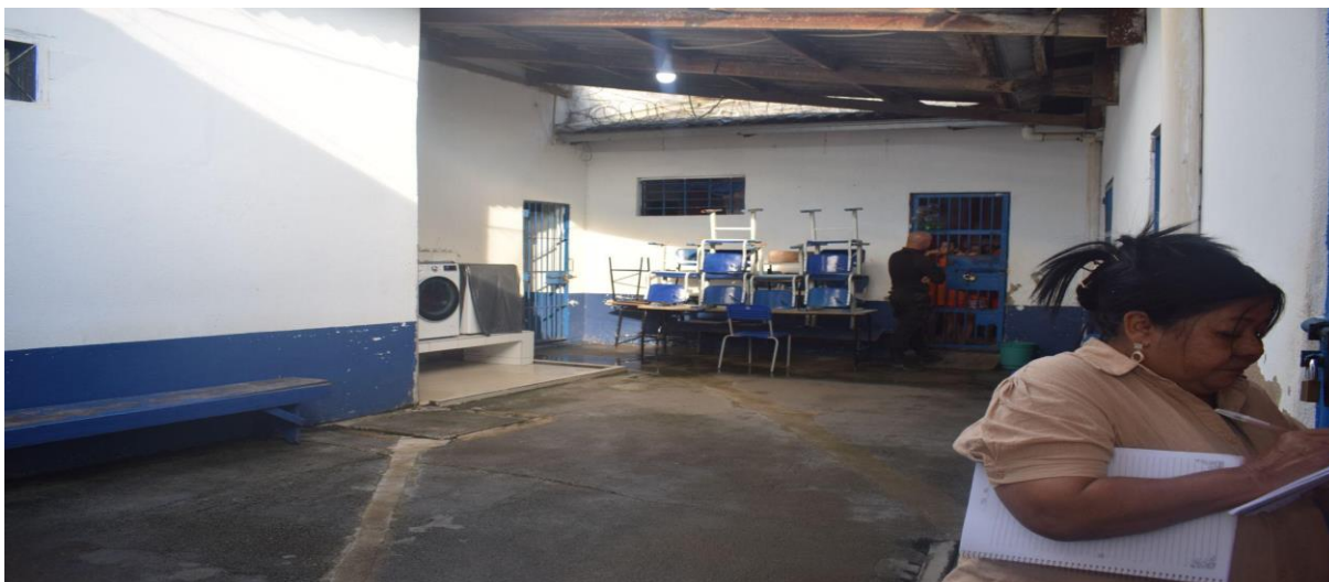
Figura 01 – Vista parcial da área de circulação interna da ala feminina durante a inspeção técnica.
