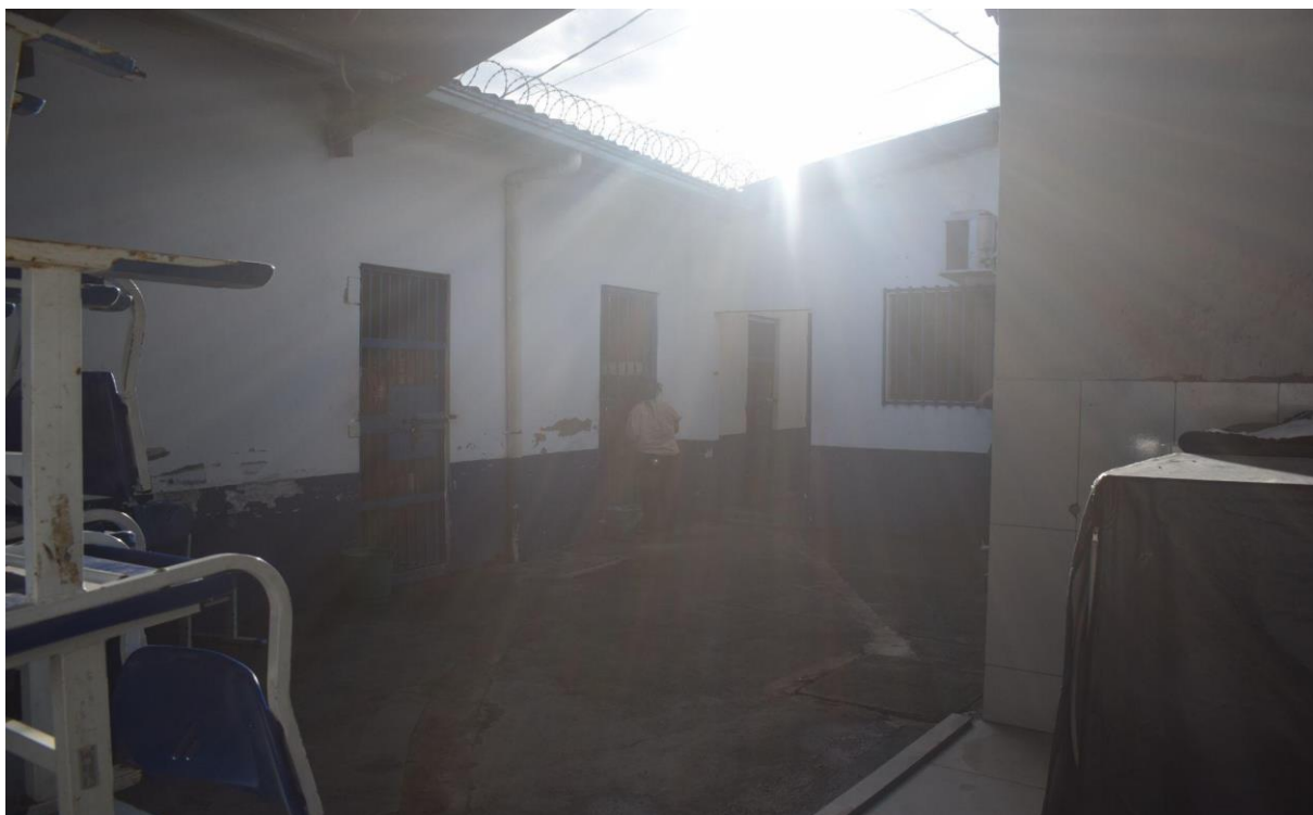
Figura 02 – Vista parcial da área de circulação interna da ala feminina durante a inspeção técnica.
