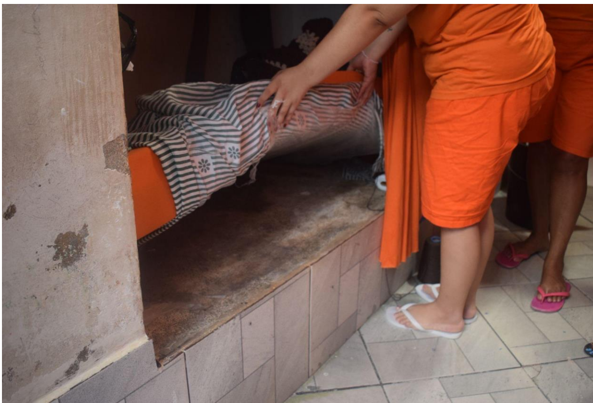
Figura 5 – Verificação das condições da estrutura destinada ao repouso das custodiadas, mediante inspeção da base de alvenaria sob o colchão durante a vistoria técnica.
