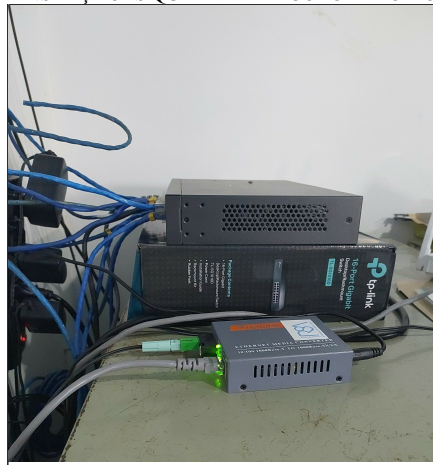
FIGURA 02 - INSTALAÇÕES QUARTEL EM COLORADO DO OESTE-RO
