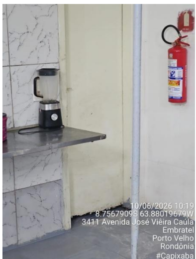
Imagens 09 e 10 – Porta da Área de Armazenamento.
