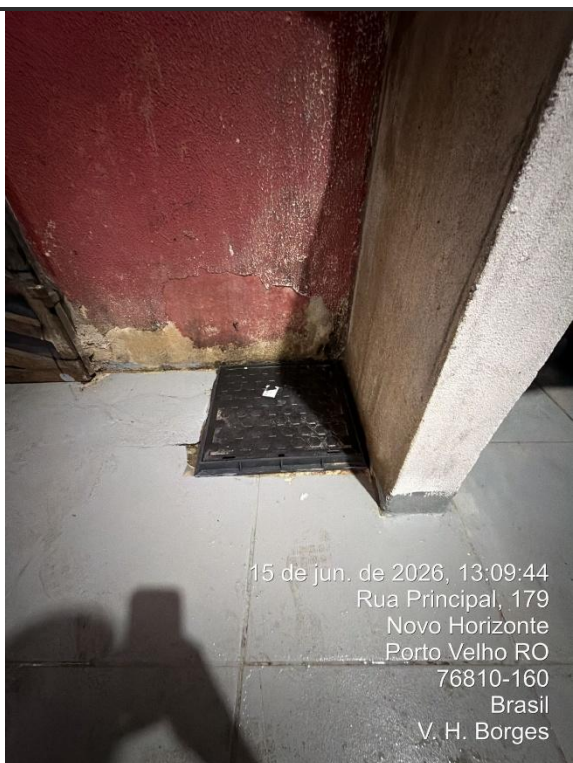
Imagem 25 - Área de lavagem.
