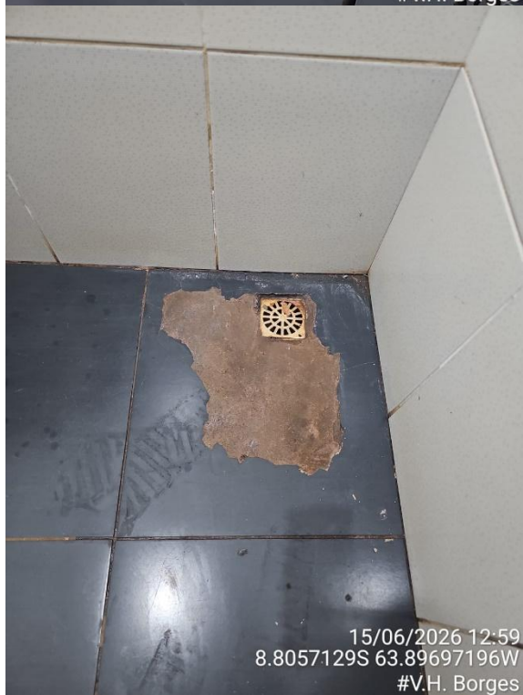
Imagens 07, 08 e 09 – Avarias nos revestimentos de piso e parede da área de refeitório.
