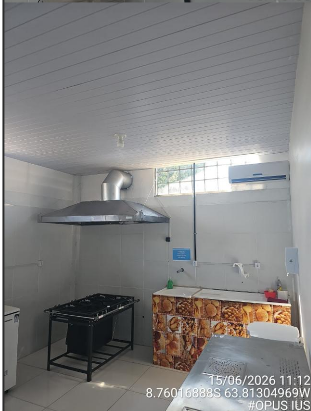
Imagens 08 e 09 - Área de preparo e armazenamento.
