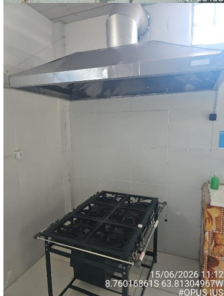
Imagens 10, 11 e 12 - Área de preparo e armazenamento.
