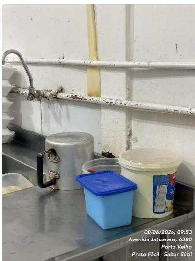
Imagens 06 a 10 – Revestimentos da Área de Armazenamento e Área de Preparo.
