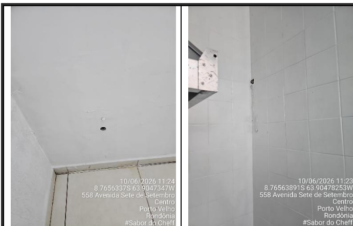
Imagens 05 a 08 – Área da cozinha
