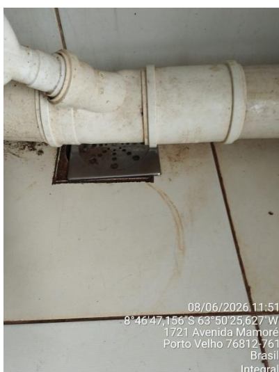
Imagem 15 – Ralo sifonado na Área de Preparo.
