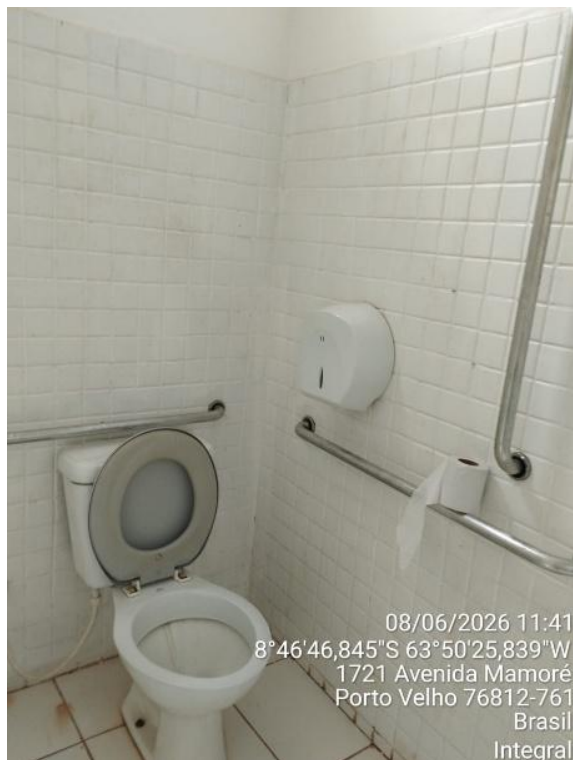
Imagem 08 – Instalação sanitária PcD.
