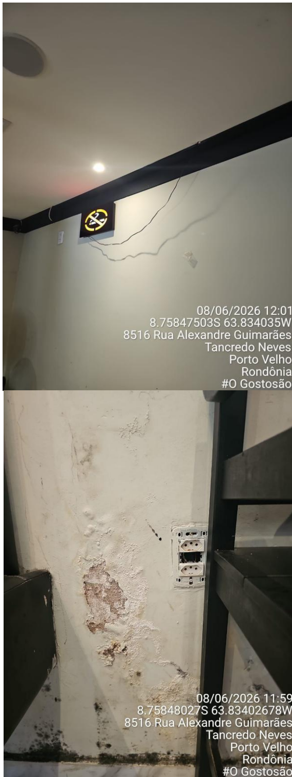
Imagem 11 - Área de Atendimento/Refeitório
