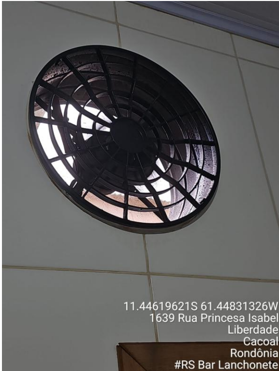
Imagem 08 - Área de preparo, manipulação e armazenamento.
