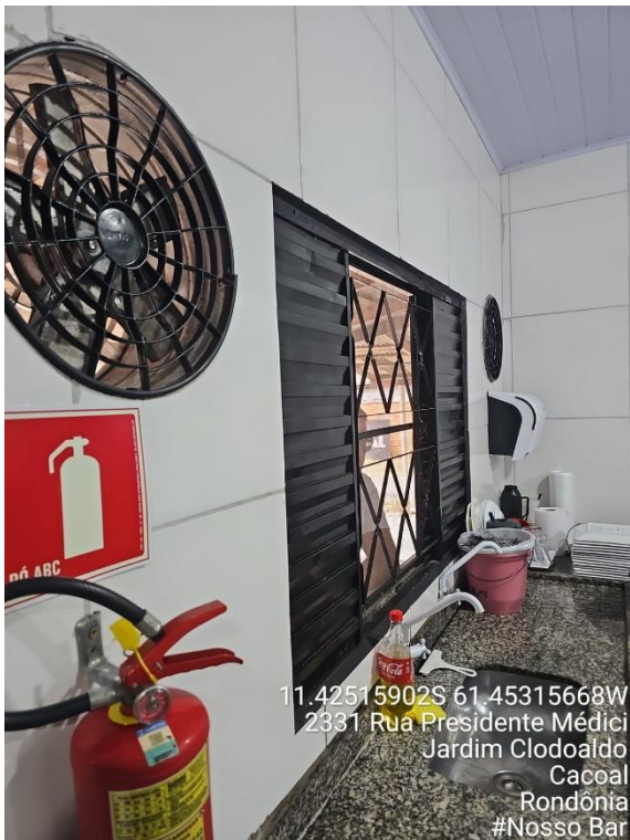
Imagem 06 - Área de preparo, manipulação e armazenamento.
