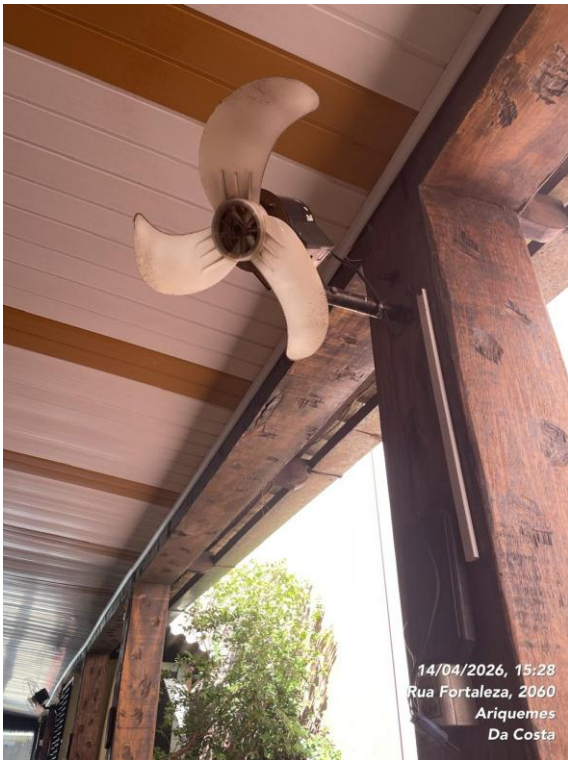
Imagem 21 – Ventilador na área de refeitório.
