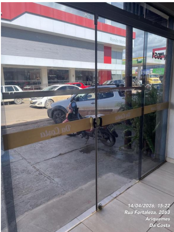
Imagem 07 – Rampa de acesso.
