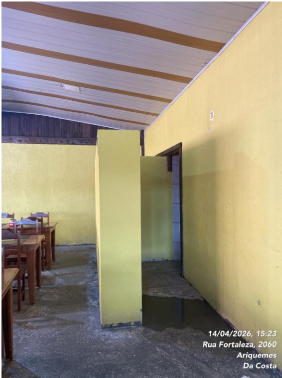
Imagem 08 – Instalação sanitária convencional.
