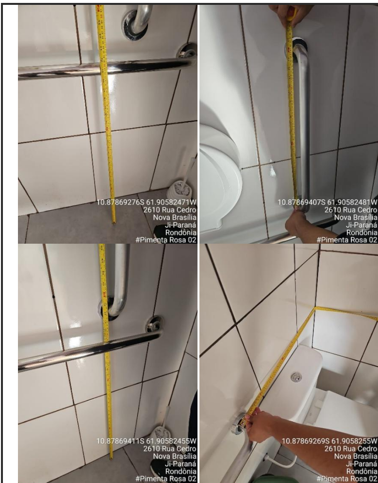
Imagem 13, 14, 15, 16, 17, 18, 19 e 20 – Banheiro PCD.
