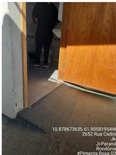
Imagem 08 – Rampa do banheiro PCD.
