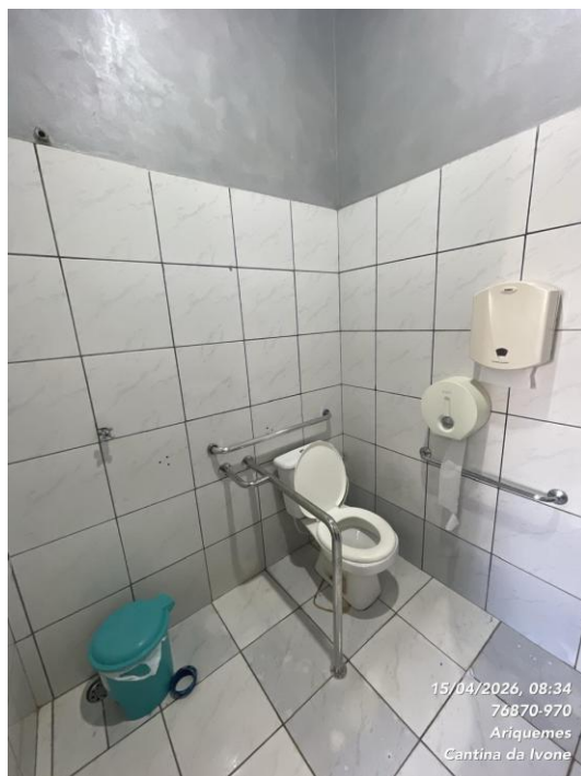
Imagem 07 – Instalação sanitária PcD.
