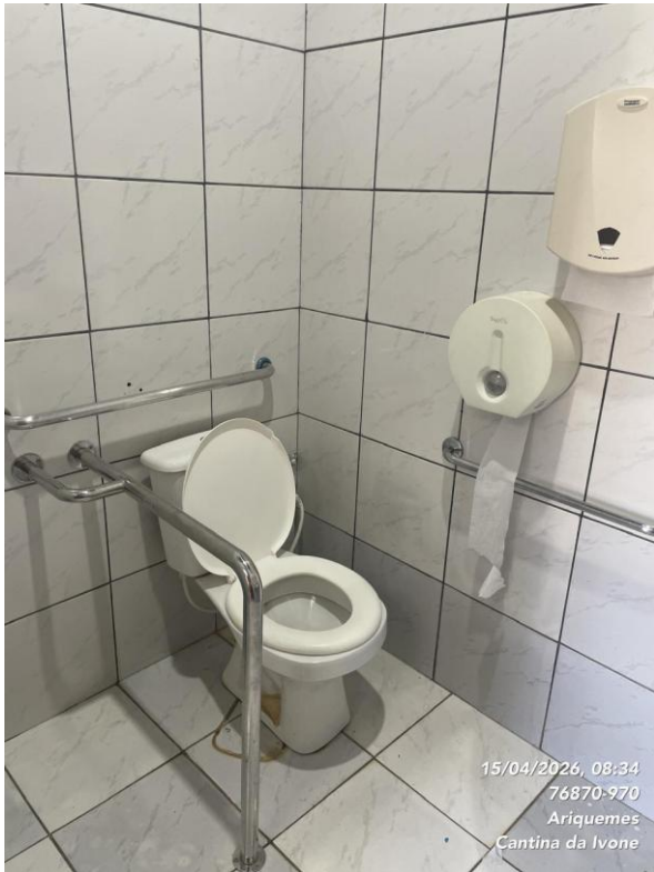
Imagem 06 – Instalação sanitária PcD.
