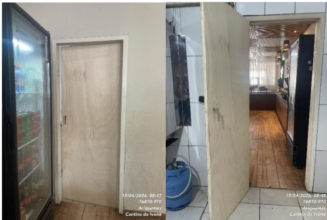
Imagens 10 e 11 – Porta de entrada à Área de Preparo.
