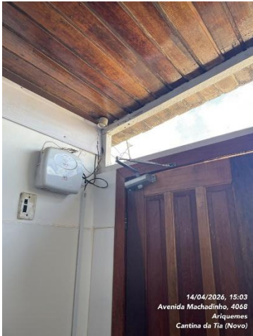
Imagens 07 e 08 – Porta de acesso à área externa.
