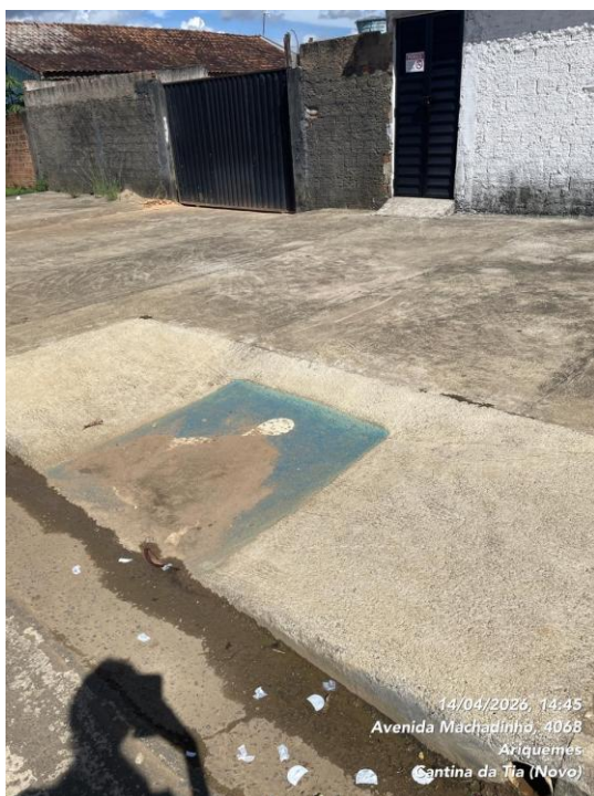
Imagem 01 – Rampa na calçada.
