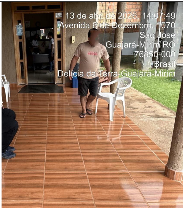
Imagem 06 - Rampa de acesso ao banheiro
