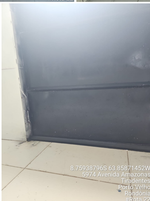
Imagens 02 a 04 - Portas da Área de Atendimento e Área de Preparo.
