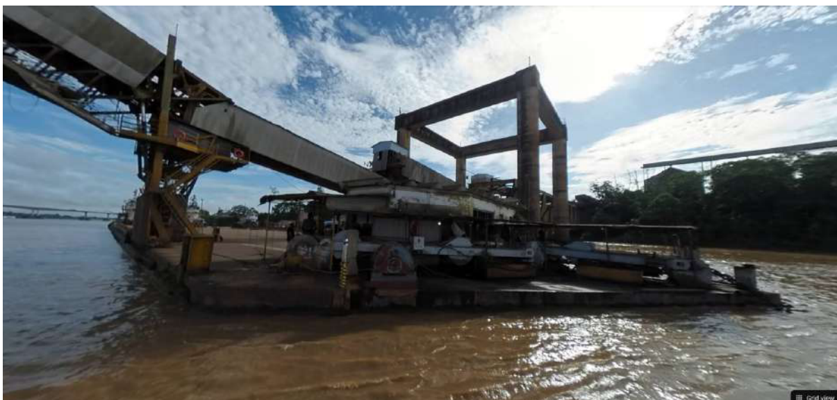
FIGURA 05 - PROA DO CAIS FLUTUANTE
