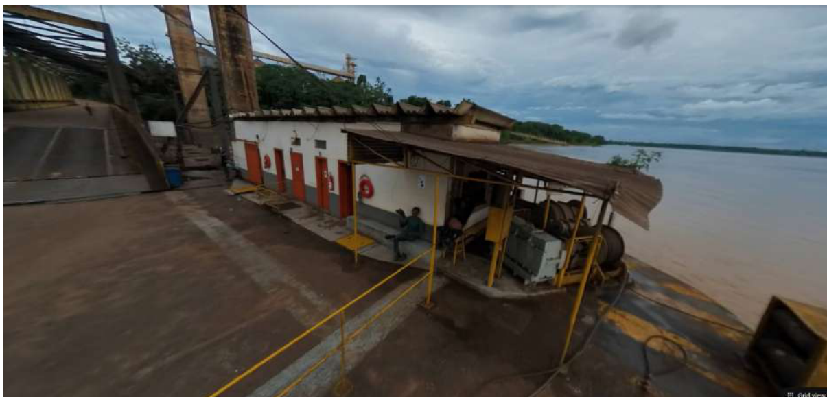
FIGURA 04 - EDIFICAÇÃO DE APOIO
