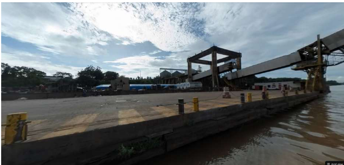
FIGURA 08 - LATERAL CAIS FLUTUANTE
