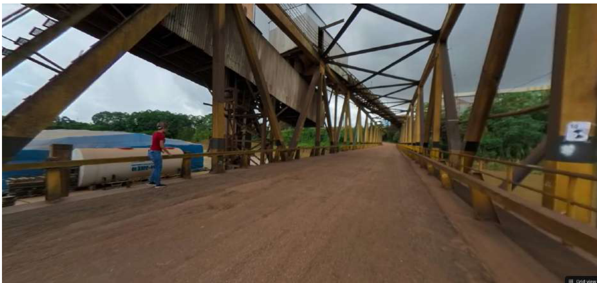
FIGURA 02 - PONTE DE ACESSO
