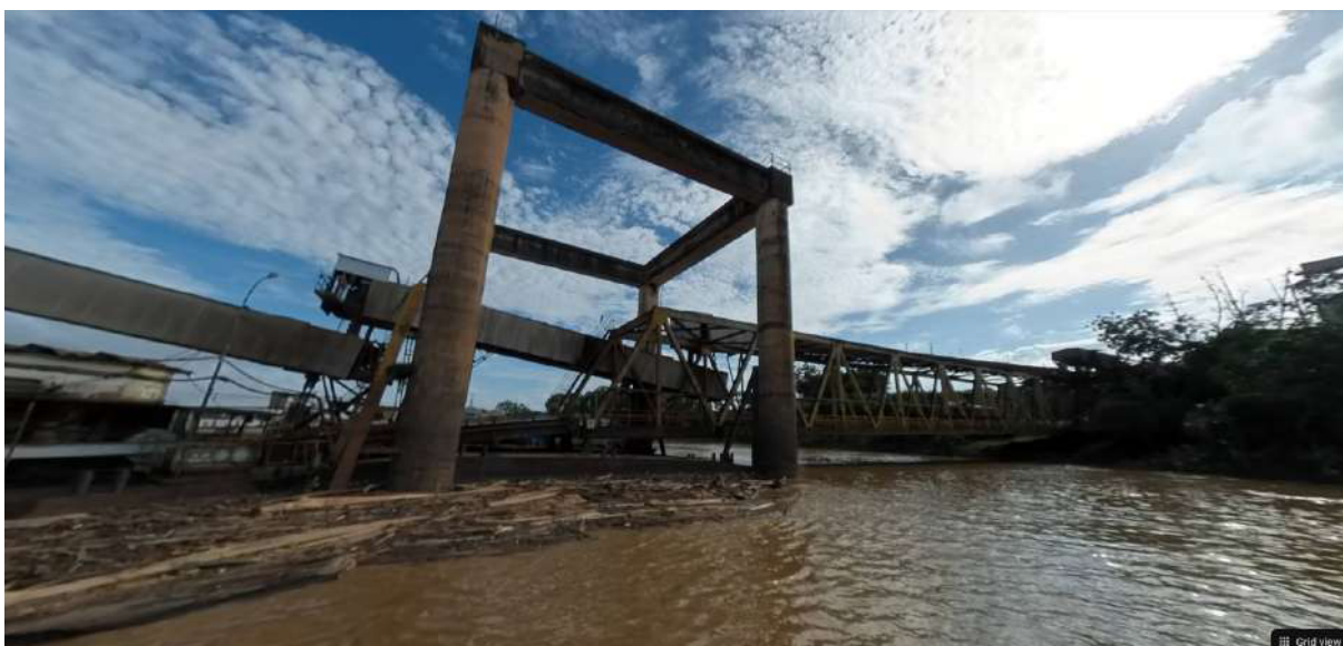
FIGURA 03 - PÓRTICO DE SUSTENTAÇÃO
