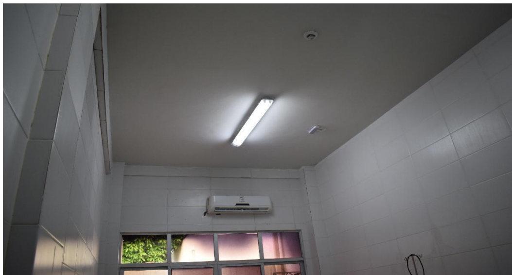
Imagem 1 – Teto da Sala de Emergência da Ala Psiquiátrica Masculina. Após reforma- Foto produzida pelo MEPCT/RO.
