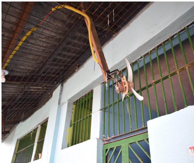
Imagem 7 - Ventilador com componentes elétricos expostos. Imagem 8 - Ventilador com fiação exposta e suspenso com barbantes.
