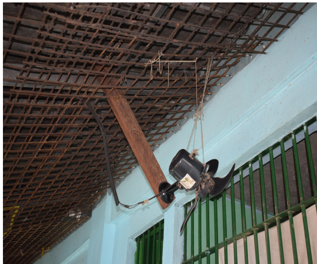
Imagem 7 - Ventilador com componentes elétricos expostos. Imagem 8 - Ventilador com fiação exposta e suspenso com barbantes.
