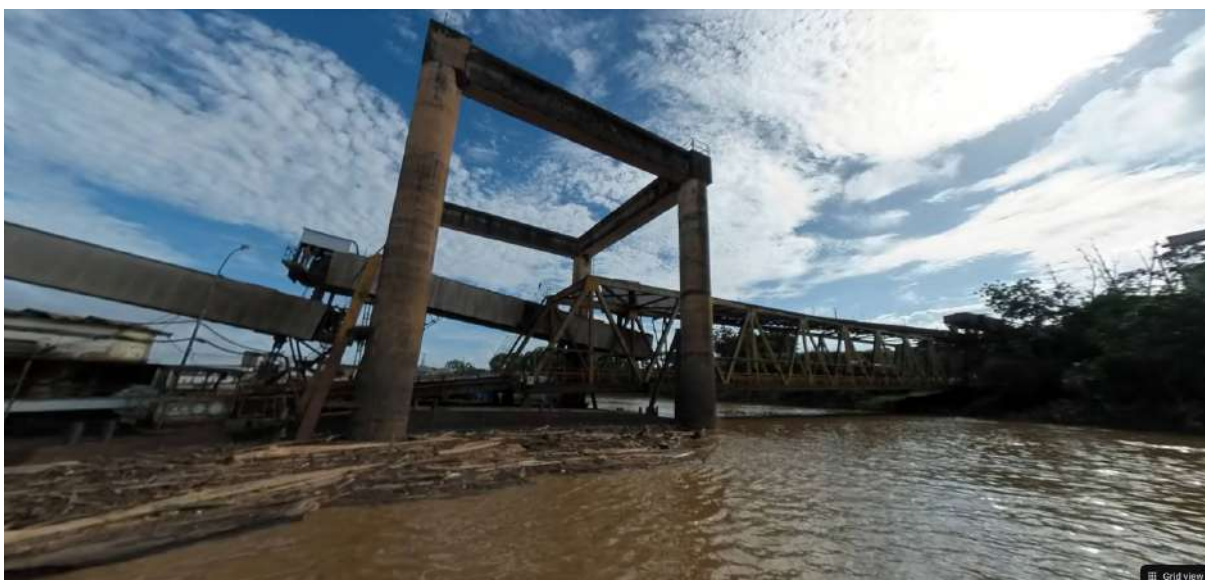
FIGURA 03 - PÓRTICO DE SUSTENTAÇÃO
