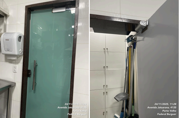
Imagem 28 e 29 - Porta DML com fechamento automático.
