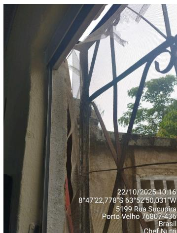
Imagen 01 - Tela da janela da cozinha mal posicionada.
