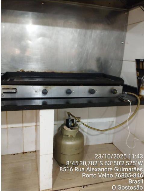
Imagem 06 - Botijão de gás na área interna.
