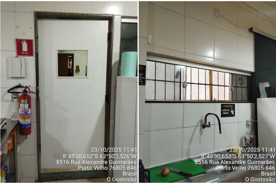
Imagens 04 e 05 - Porta de entrada e janela da área de preparo.
