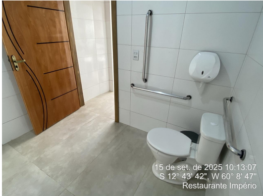
3.3 - Instalações Sanitárias PCD - Porta de acesso com 0,80m de vão livre e sentido de abertura para fora
