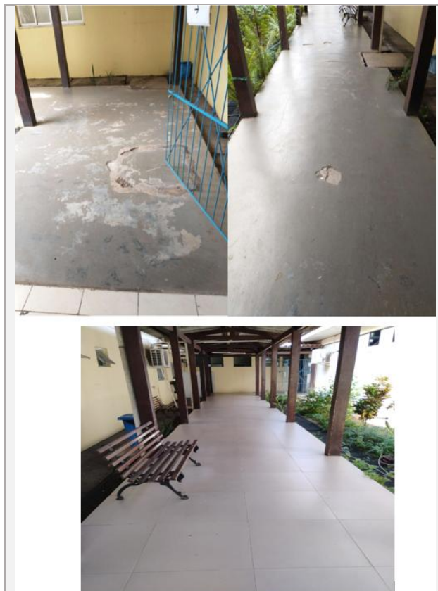
Figura 241 - Troca de piso do corredor de entrada CDMM
