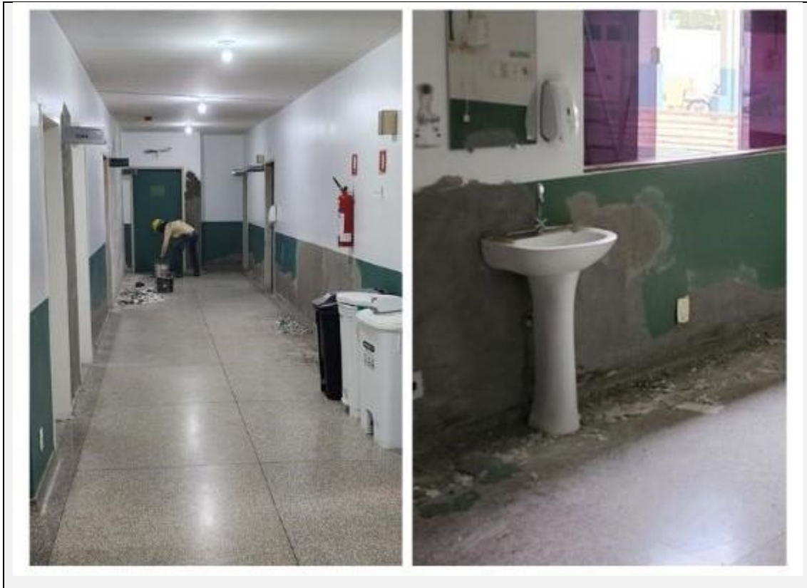
Figura 188 - Ambientes Sendo Reformados
