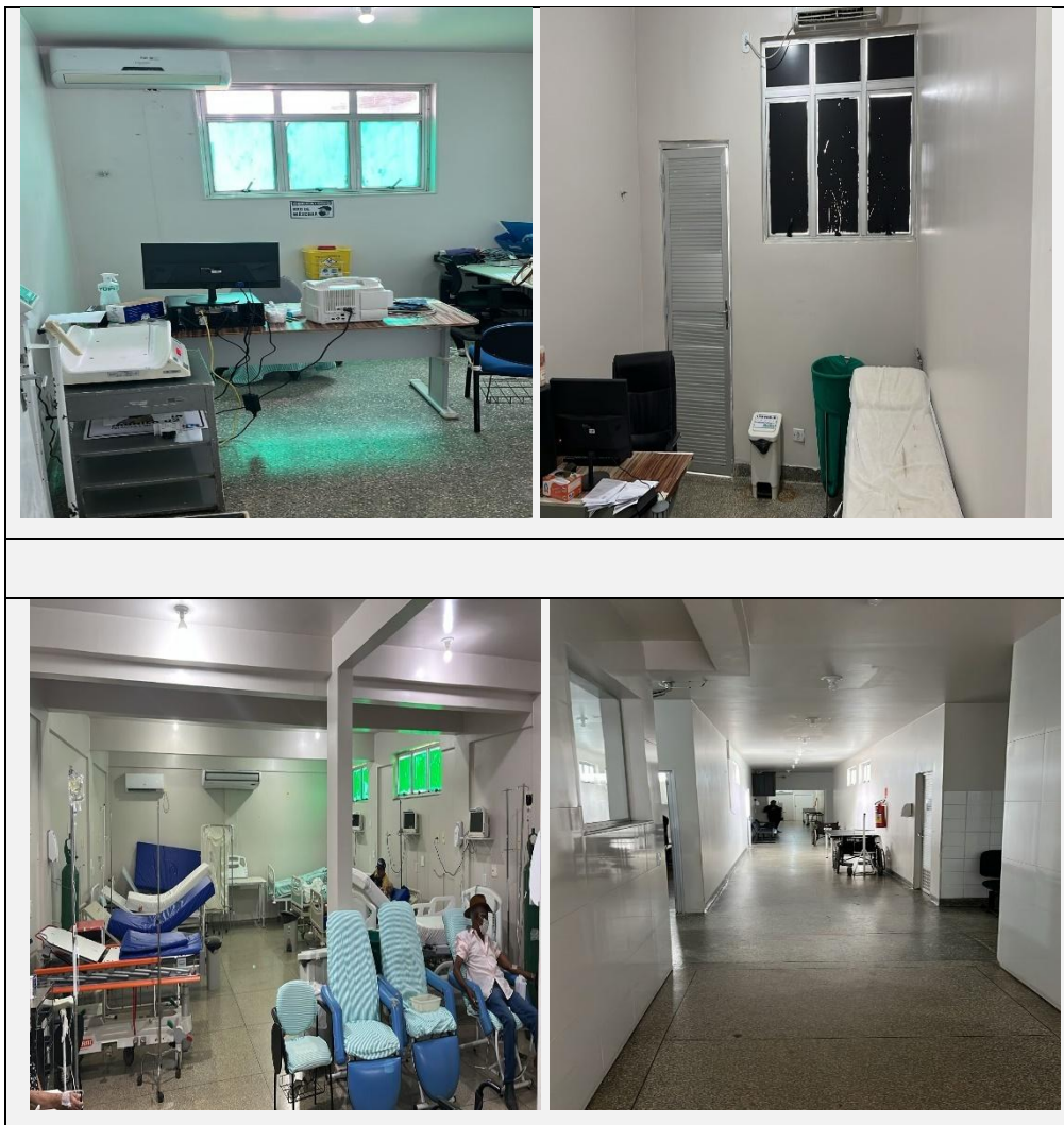
Figura 207 - Pintura e Restauração da Sala de Observação - HRB
