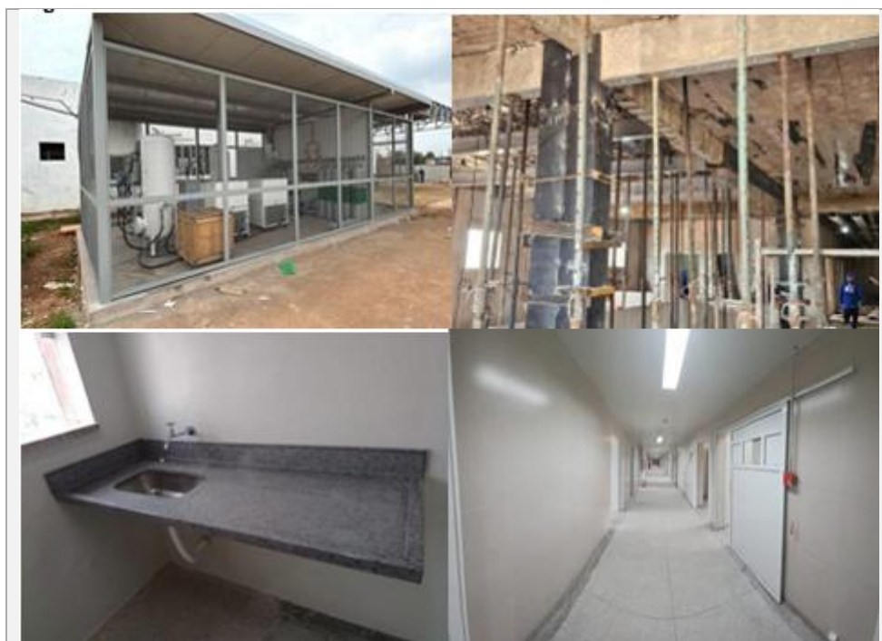
Figura 284 - Obras do CEMETRON
