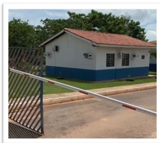
Figura 201 - Instalação da Cancela Eletrônica na entrada do Estacionamento do HRC, Cacoal, 2024
