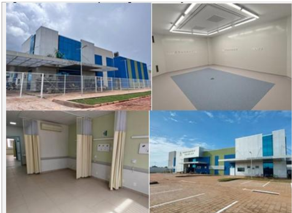
Figura 283 - Obras do Hospital Regional de Guajará-Mirim
