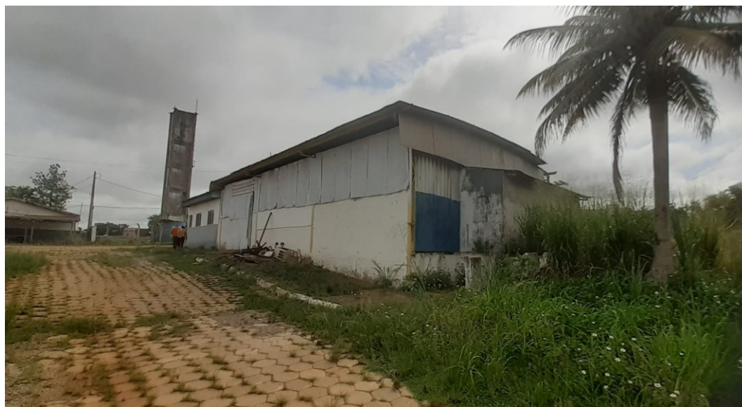
Imagem Externa do Armazém Pequeno
