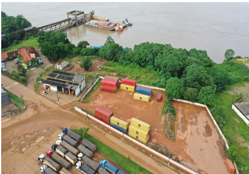
Vista aérea da oficina e pátio alfandegado
