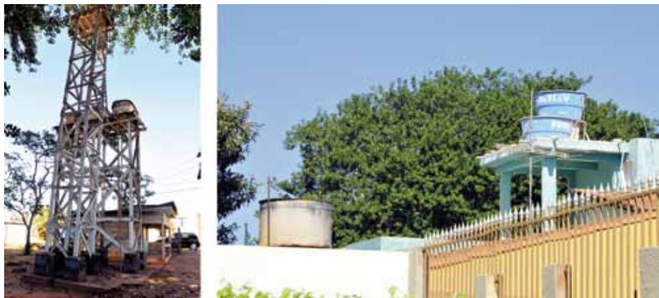
Figura 12. Depósitos de água elevados.
