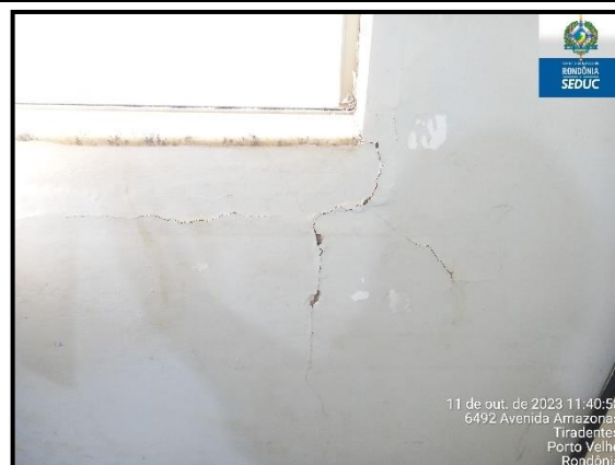
Fissura contraverga
