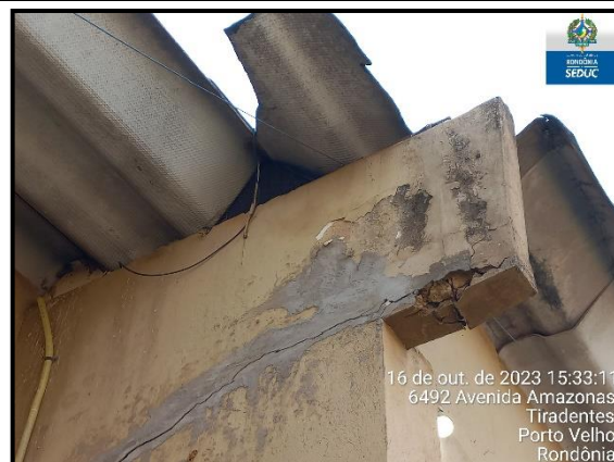
Viga apresentando trincas, fissuras e exposição de armadura
