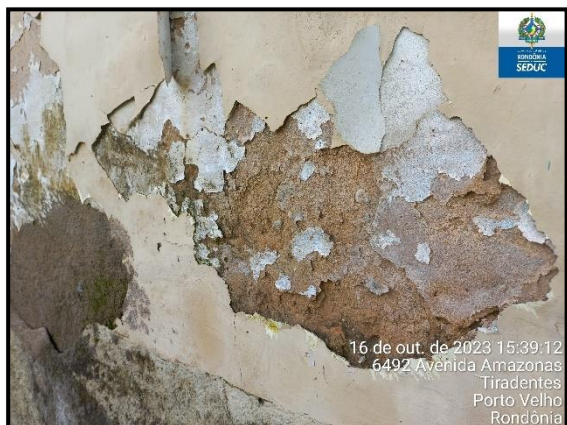
Desplacamento de Acabamento e Revestimento exposto (recobo aparenta com seu Mpa baixo)
