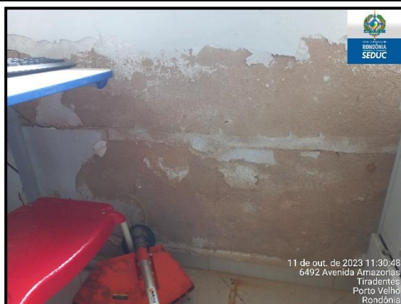
Revestimento exposto (recobo aparenta com seu Mpa baixo)
