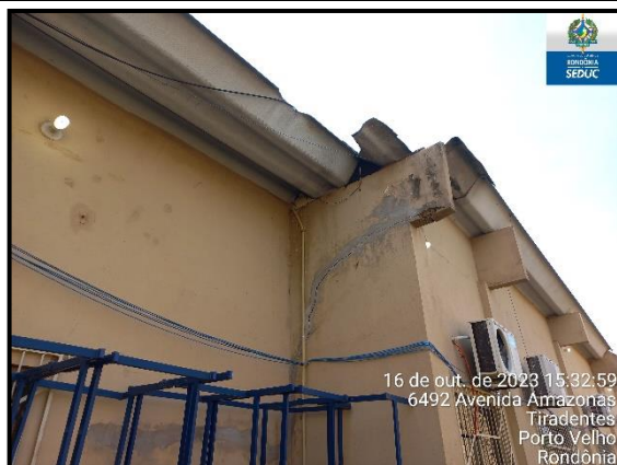
Telhas danificadas nas passarelas de circulação
