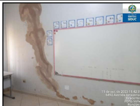
Trinca nas paredes das salas de aulas
