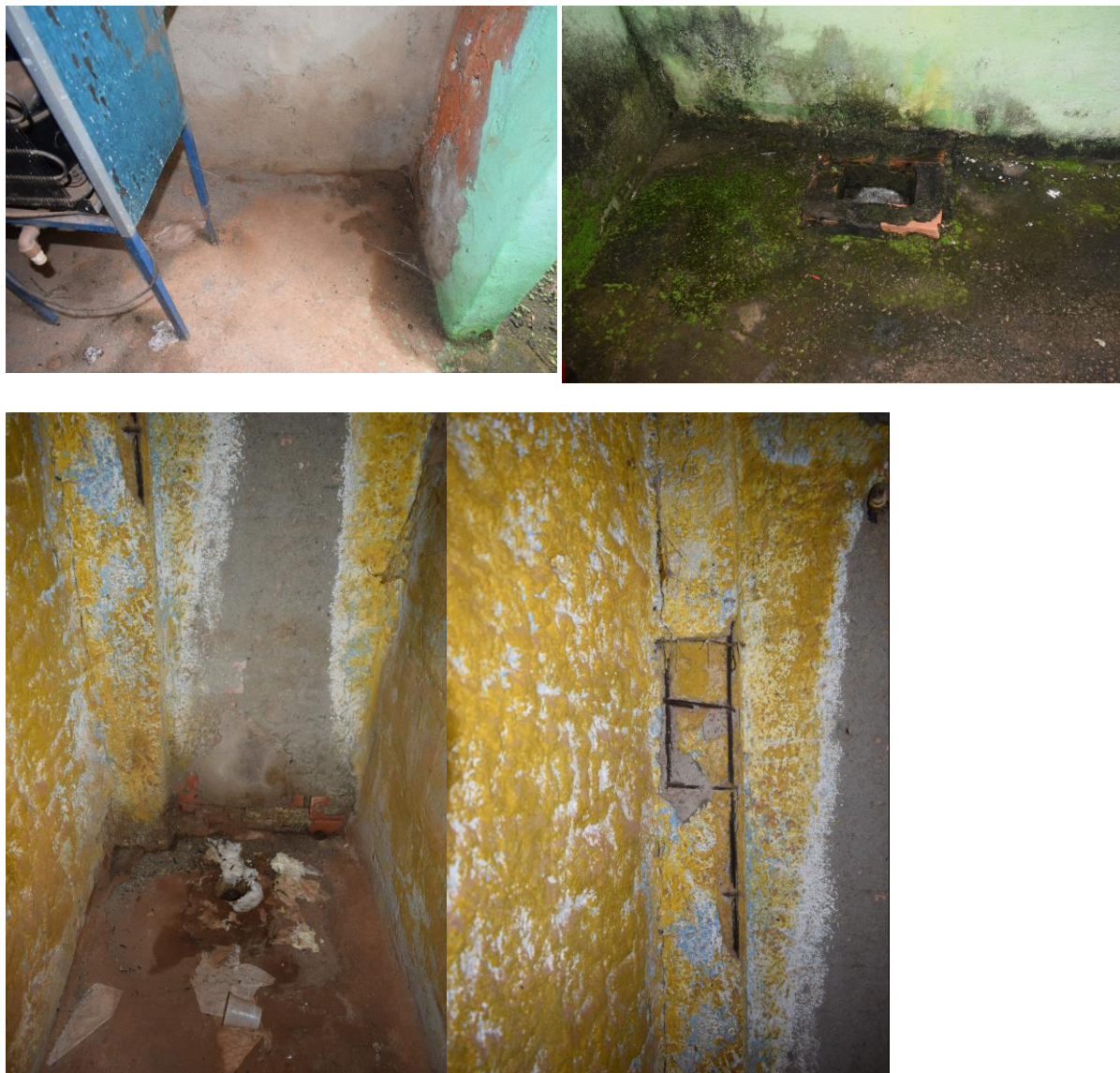
Figura 8 – Casa de Detenção de Guajará-Mirim – Estrutura da guarita apresenta umidade e ferragens expostas (Foto produzida pelo MEPCT/RO).
