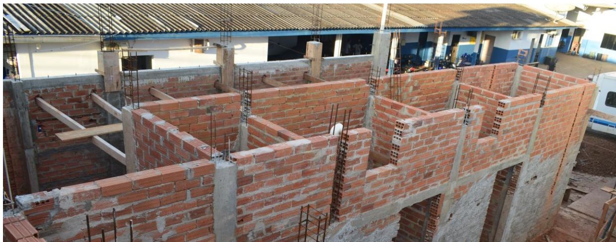
Figura 2 - Construção o espaço que será destinado à realização da visita conjugal, ampliação das salas de aula e setor administrativo (obra vista de cima). Imagens produzida pelo MEPCTR/RO.
