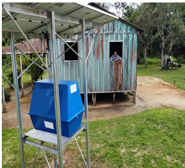
Imóvel beneficiado por sistema solar de geração de energia.
