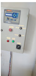
FOTO INSPEÇÃO 04.jpeg 179K
