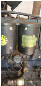
FOTO INSPEÇÃO 01.jpeg 85K
