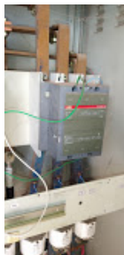
FOTO INSPEÇÃO 02.jpeg 173K
