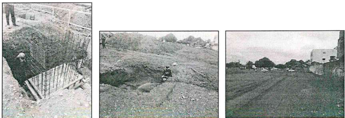
Figura 24 - Fundação para construção do novo galpão alfandegado
