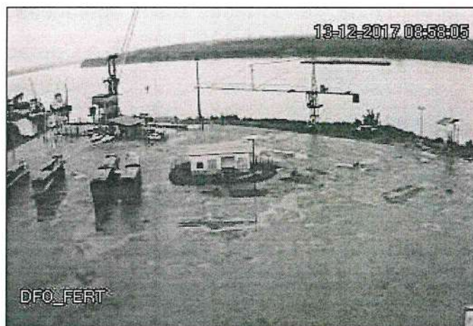
Figura 16 - Monitoramento Eletrônico pátio das gruas
