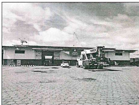
Figura 11 - Adaptação do armazém de carga geral
