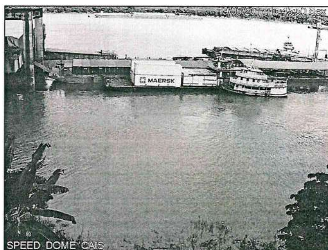
Figura 15 - Monitoramento Eletrônico cais flutuante
