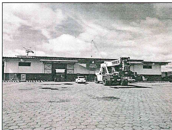
Figura 11 - Adaptação do armazém de carga geral
