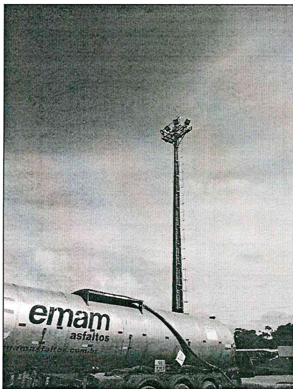
Figura 6 - Poste instalado com iluminação Led
