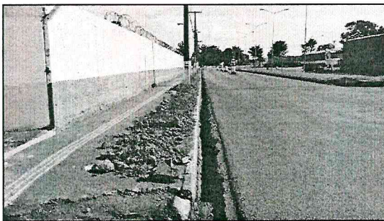
Figura 22 - Construção da rampa e instalação de condutores de águas pluviais
