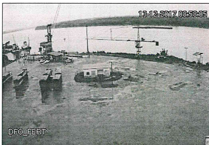
Figura 16 - Monitoramento Eletrônico pátio das gruas
