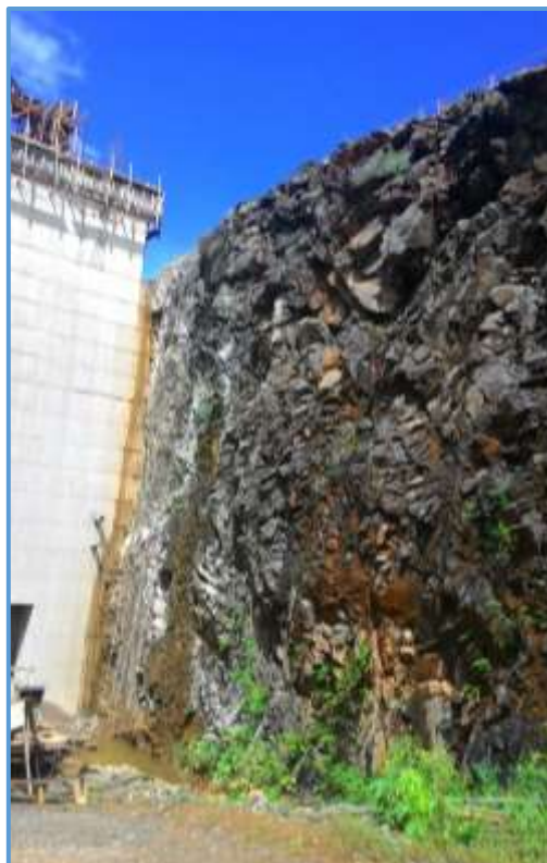
Foto 18. Vista da rocha na margem direita onde se observam estruturas de dobramento, metamorfismo e faturamento; por fim, o intemperismo alterando os minerais e mudando a cor da rocha de cinza para marrom.
