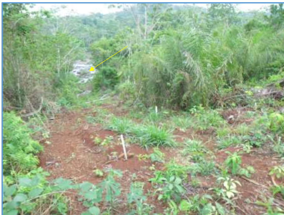
Foto 23. Vista do topo da margem esquerda, antes da implantação do reservatório, onde se observa o rio ao fundo e a diferença de cota indicando um terreno íngreme recoberto de solo de alteração da rocha.
