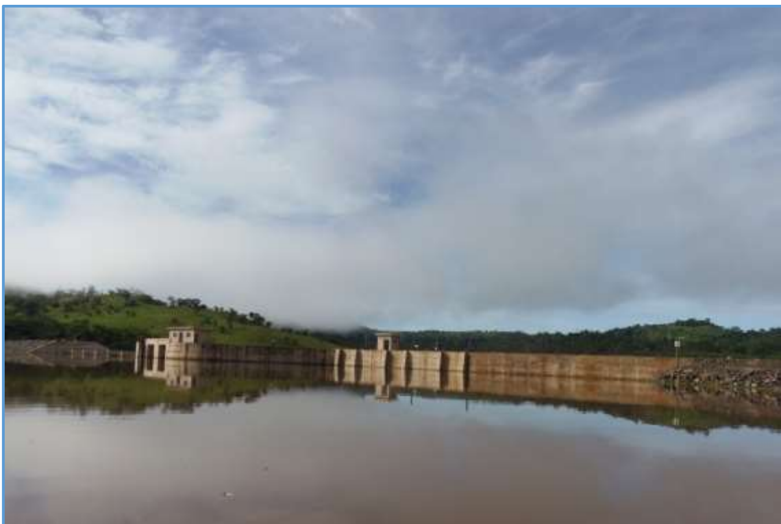
Foto 8. Barragem da Hidroelétrica Cachimbo Alto Ltda - contida no Q2.
