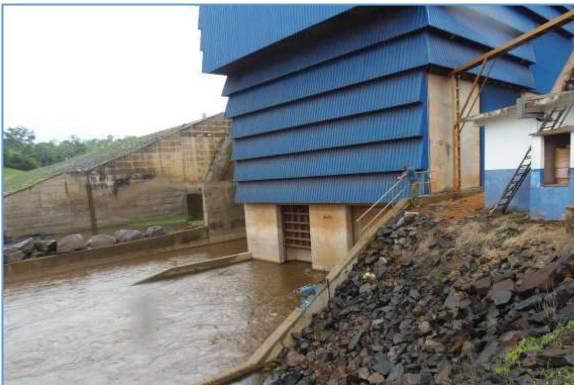
Foto 16. Casa de força e barragem da PCH Ângelo Cassol contido no Q6.
