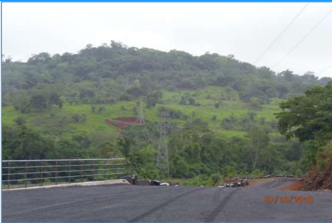
Foto 3. Linha de transmissão da Hidroelétrica Cachimbo Alto Ltda, área de vegetação ao fundo e uso agropecuário no Q2.
