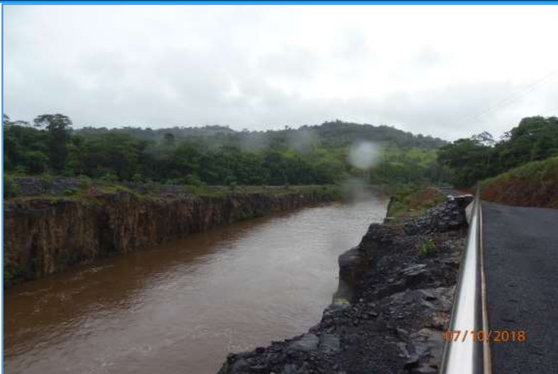
Foto 5. Canal de fuga da Hidroelétrica Cachimbo Alto Ltda - contida no Q2.
