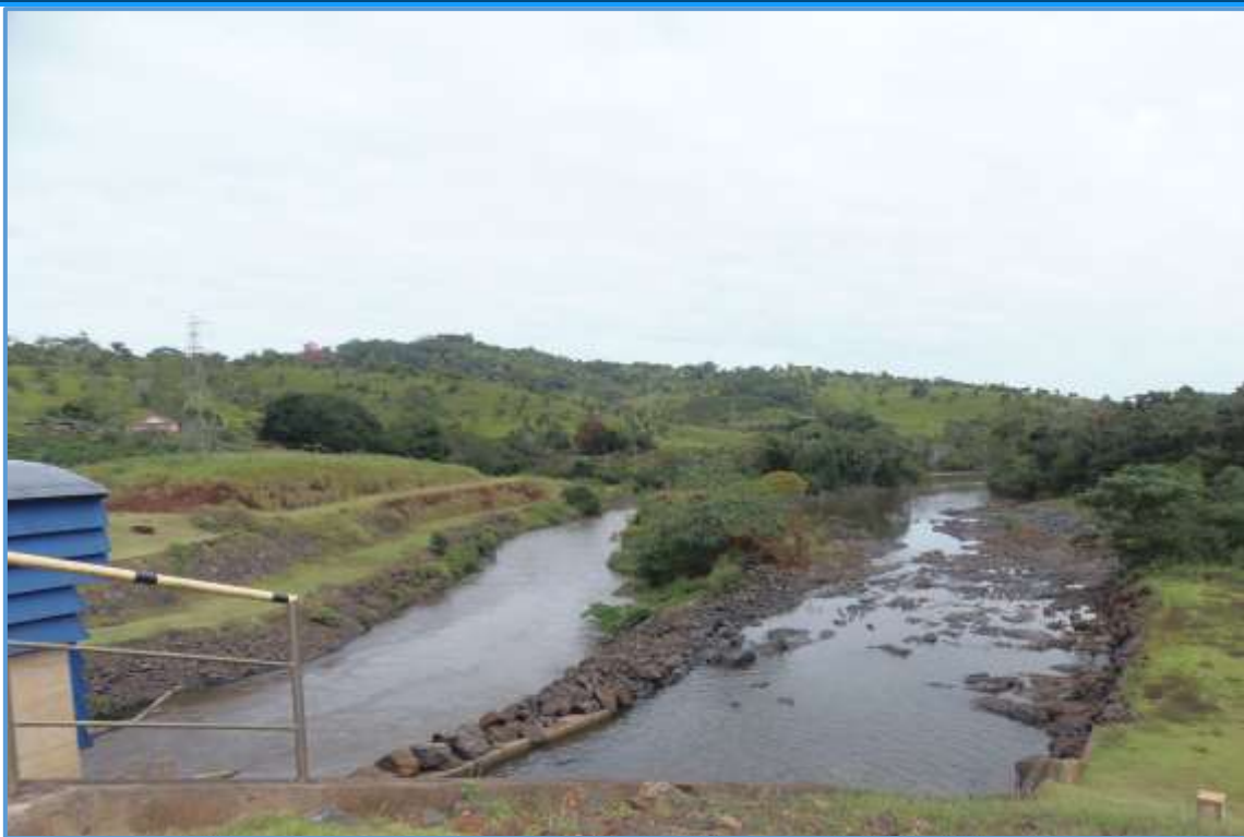
Foto 15. Leito natural do rio Branco e canal de fuga da PCH Ângelo Cassol contido no Q6.
