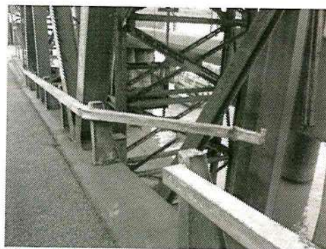
20 - Instalação de Guard Rails.
