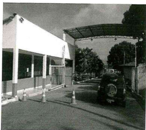
13 – Construção de guarita.
