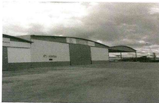
16 - Construção do armazém alfandegado.
