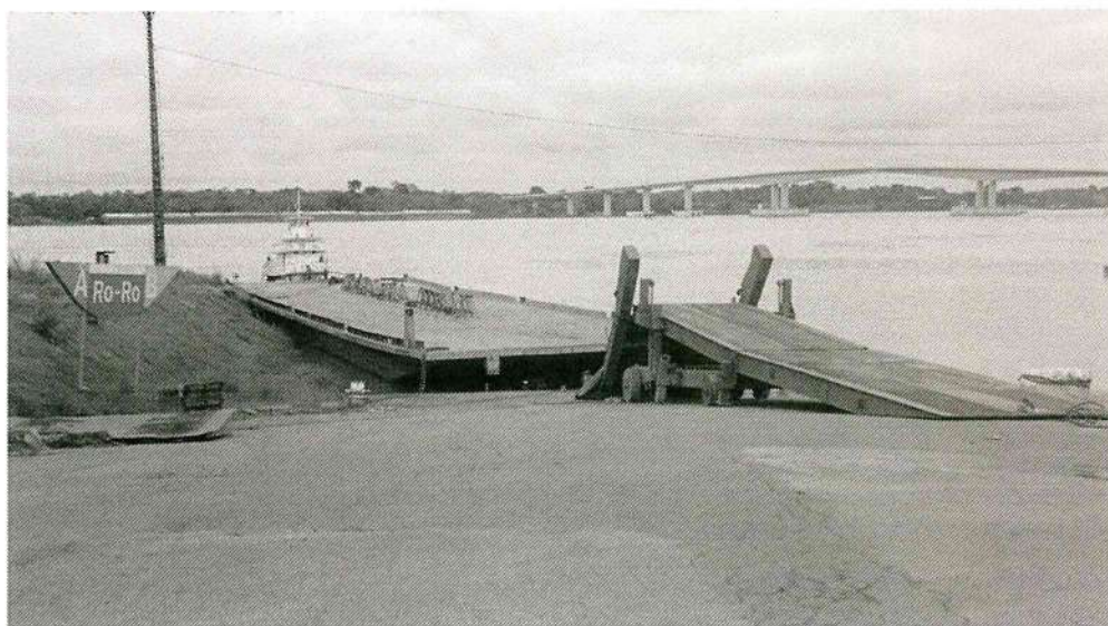
Rampa Charriot no Ponto de Atracação das Rampas Ro/Ro
