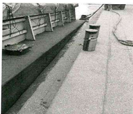
19 - Substituição de defesa do cais flutuante.
