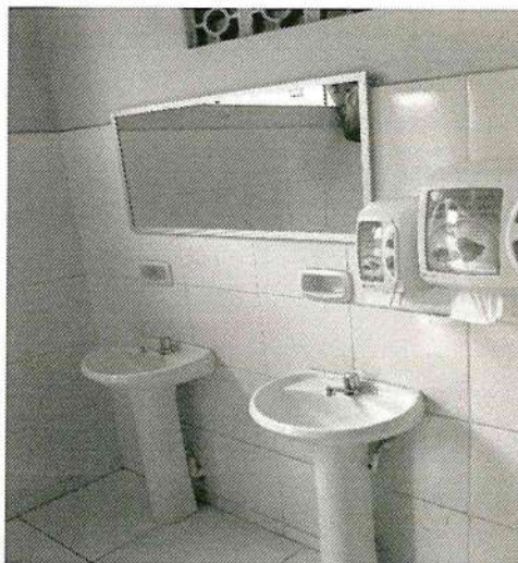
24 – Reforma e Adequação de banheiros do Porto.
