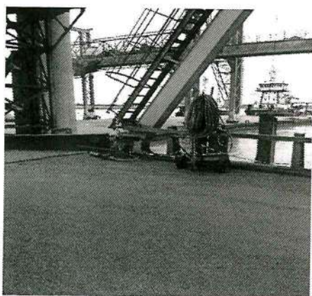
17 - Reparos na ponte de acesso do cais flutuante.
