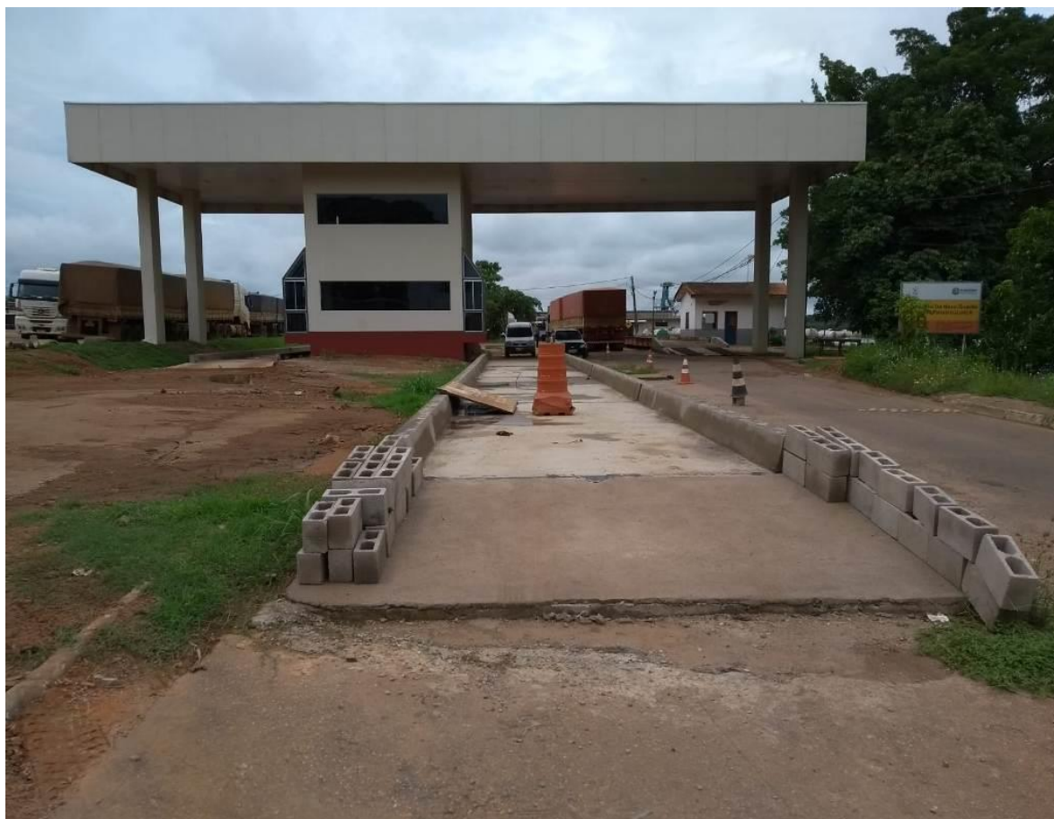
Figura 28 - Construção da Balança Rodoviária Eletrônica da SOPH
